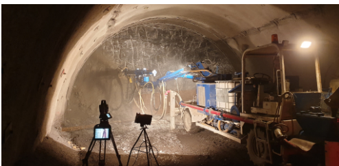
Der flüssige Spritzbeton wird auf die Tunnelwand über eine Düse aufgetragen.
