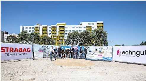
Das wohngut-Team mit Geschäftsführer Lukas Sykora freut sich gemeinsam mit Herbert Vanzo (STRABAG) sowie Jochen Hoog und Ulrike Pitro (ASAP) über den Spatenstich zu "DUO 22".
