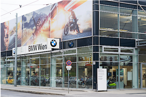
Aussenansicht Heiligenstädter Strasse 64.
