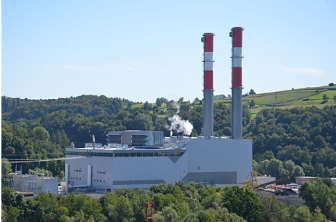
Gas- und Dampfturbinenkraftwerk Mellach
