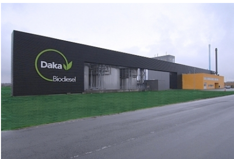
Außenansicht der BioDiesel-Anlage DAKA.
